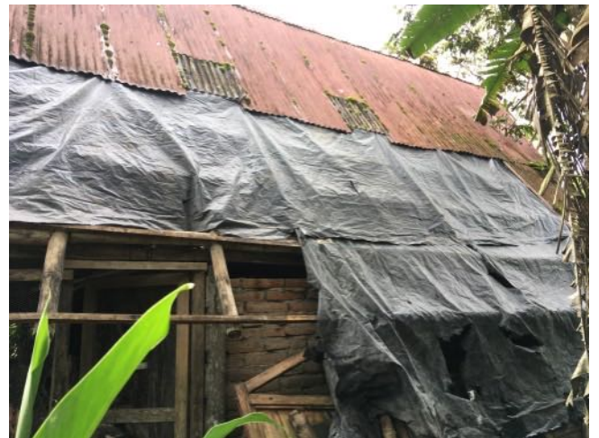
Teile der Dachbedeckung wurden schon abmontiert und für den neuen Werkzeugschuppen wiederverwendet.
